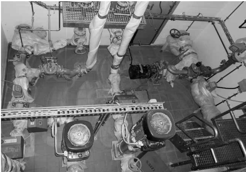
Erneuerte Installationen im Reservoir Egg während der Bauphase
