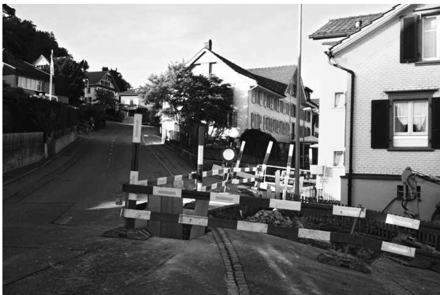
Sanierungsarbeiten an der Binzstrasse
