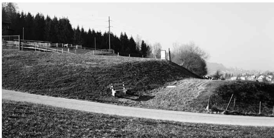
Endgestaltung nach Rückbau des alten Reservoirs Sonnenberg oberhalb Bichwil
