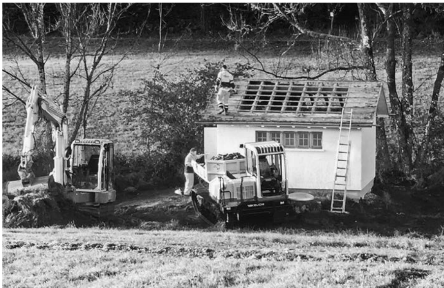
Rückbau des nicht mehr benötigten Pumpenhauses im Schooren, Oberuzwil
