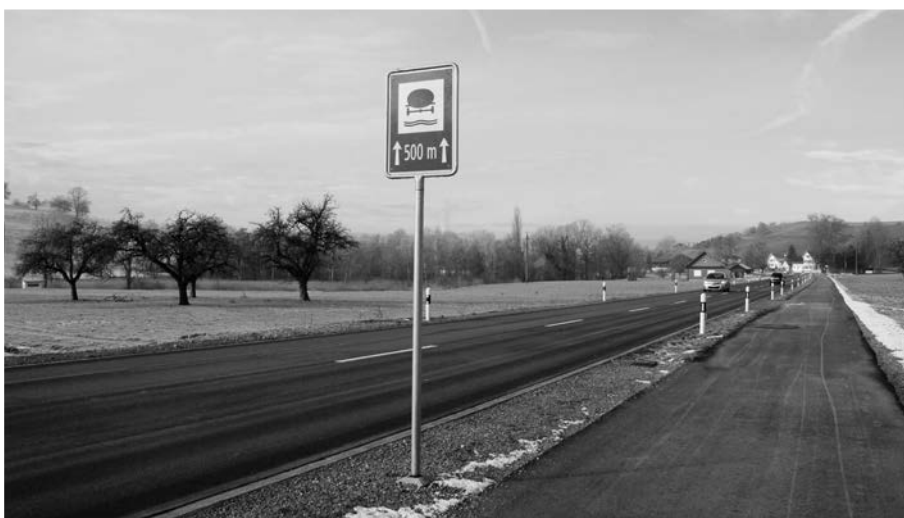
Markierung der Grundwasserschutzzone Schooren nach der Sanierung der Kantonsstrasse zum Bettenauer Weiher in Oberuzwil
