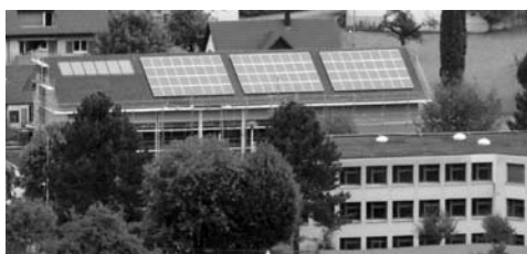
Solar- und Photovoltaik- anlage auf der MZA Bichwil
