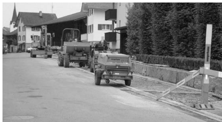
In Bichwil wurde das Trottoir entlang der Dorfstrasse ergänzt.
