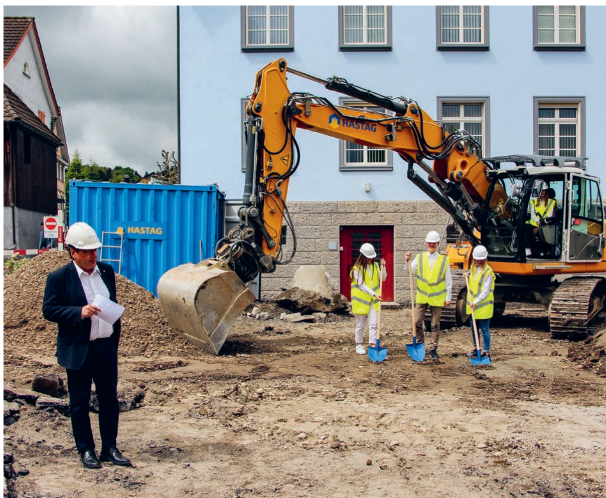
Die Lernenden der Verwaltung setzen zum Spatenstich an.
